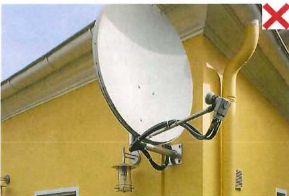
Parabolantennen an der Fassade des Gebäudes
