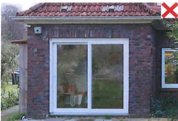
Bauzeitliche Öffnungen nicht mehr ablesbar, Fenster wurden vermauert und Stalltür wurde durch eine Schiebetür ersetzt
