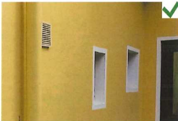
Lüftungsgitter diskret im Sichtschutz des Fallrohres auf der Gebäuderückseite angebracht
