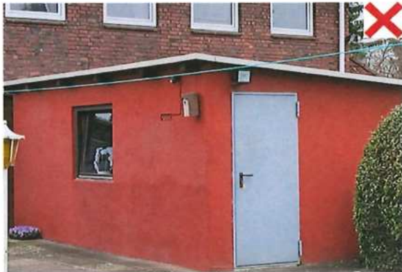
Garage mit Pultdach, Lochfassade und vom Haupthaus abweichender Fassadengestaltung
