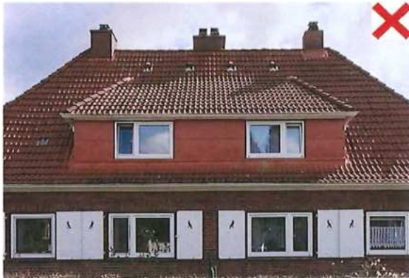
Fachwerk der Fachwerkgaube mit Blechverkleidung
