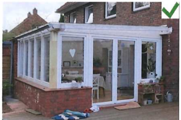
Anbau mit durchgehendem Sockel, Fensterband und Flachdach
