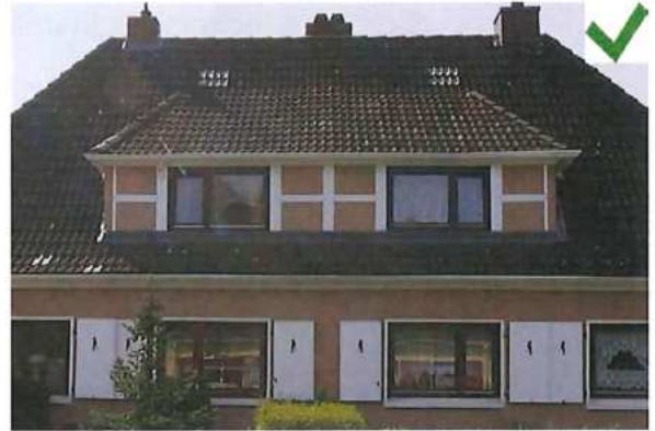
Zweifarbiges Fachwerk der Fachwerkgaube sichtbar
