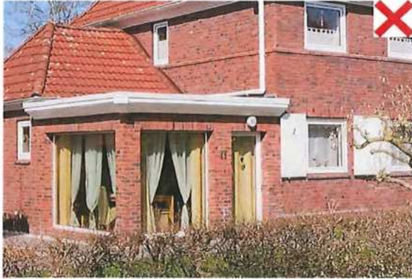
Anbau an Haustyp 11 an unzulässiger Position (straßenseitig)
