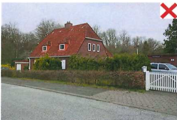
unzulässiger, vegetativer Sichtschutz hinter der zulässigen Einfriedung nimmt die Sicht auf die Fassade
