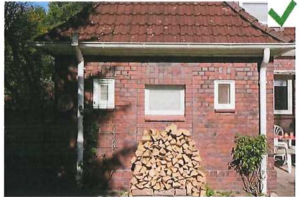
Der verwendete Stein wurde dem Bestandsgebäude entsprechend ausgewählt und nicht verzahnt vermauert
