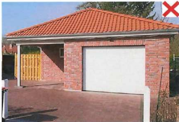
Garage mit Walmdach, Pfannendeckung und überdachter Innenecke
