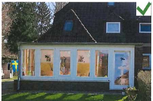
Anbau mit durchgehendem Sockel, Fensterband und Flachdach
