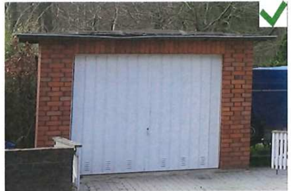
Einzelgarage mit Flachdach und Blechtor
