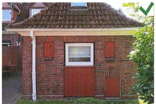
Die historischen Öffnungen sind weiterhin ablesbar, die Stalltür wurde durch ein Fenster ersetzt
