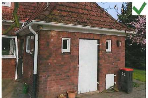
Bauzeitliche Öffnungen - sowohl Fenster als auch Stalltür - weiterhin ablesbar
