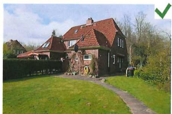
Die befestigte Fläche überschreitet nicht die zulässigen 15%, die Zuwegung ist mit denkmalgerechten Platten ausgeführt
