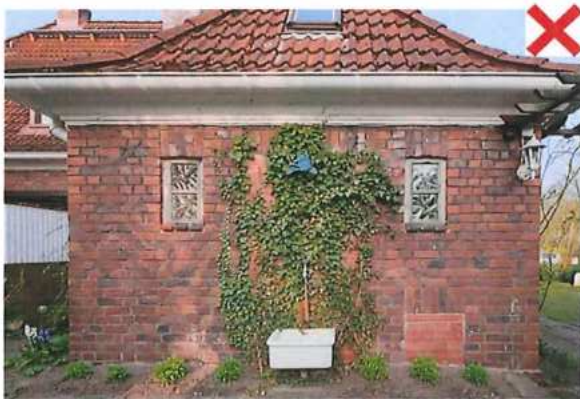
Die Öffnung der Stalltür wurde vermauert, historische Mauerwerksöffnungen sind nicht ablesbar
