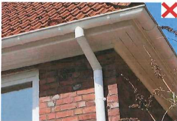
Äußerlicher Anstrich der Rinne und Fallrohe
