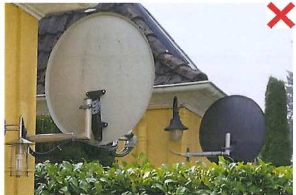
Das Anbringen von Parabolantennen ist am gesamten Gebäude unzulässig
