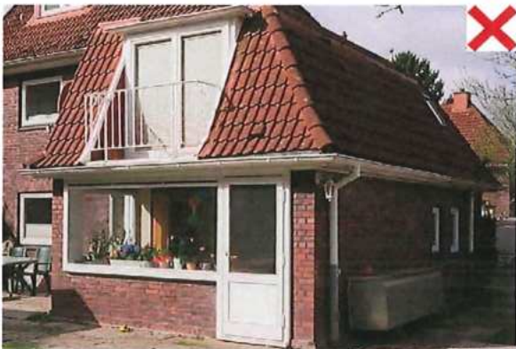
Anbau mit unzulässiger Dachform und Fensterformaten, kein durchgehender Sockel
