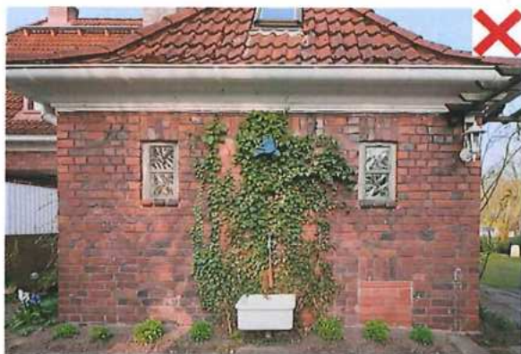
Die Öffnung der Stalltür wurde geschlossen und ist nicht mehr ablesbar
