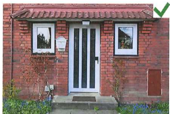
Bauzeitliches Betonpodest materialsichtig belassen
