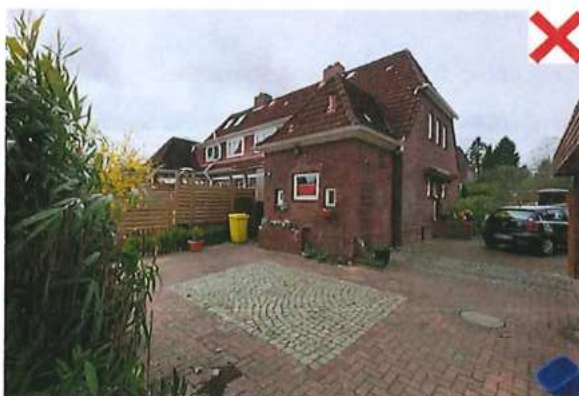
Die befestigte Fläche überschreitet die zulässige Maximalfläche von 15% der Grundstücksfläche
