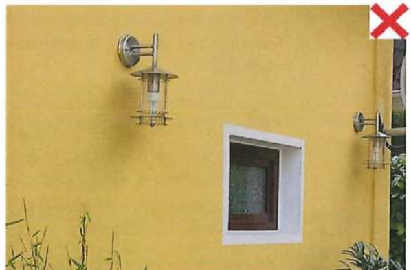
Das Anbringen von Leuchten, zusätzlich zu den Eingangs- und Nebeneingangsleuchten, ist unzulässig.
