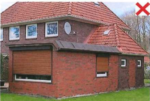
Anbau mit unzulässigen Fensterformaten, Steinwahl ist nicht dem Haupthaus entsprechend
