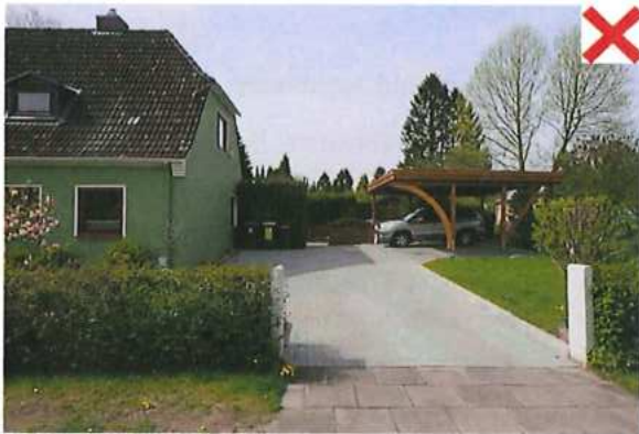
Maximal zulässige Zufahrtsbreite überschritten, Pforte fehlt
