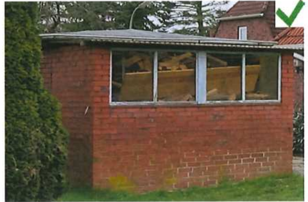
Nebengebäude mit horizontaler Traufe, Fensterband und dem Haupthaus entsprechendem Fassadenmaterial
