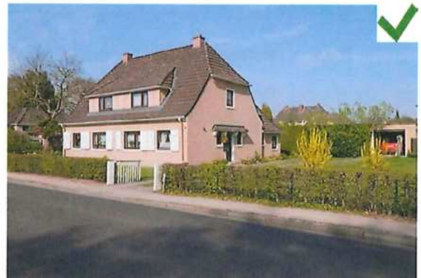
Denkmalgerechte Ausführung, die Zufahrt besteht aus zwei separaten Radspuren aus Betonplatten
